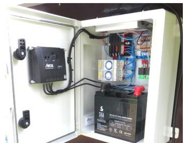
Photovoltaikanlage 12V 150WP mit Laderegler und Akku
