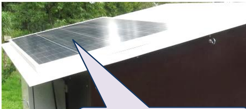
Photovoltaikanlage 12V 150WP mit Laderegler und Akku
